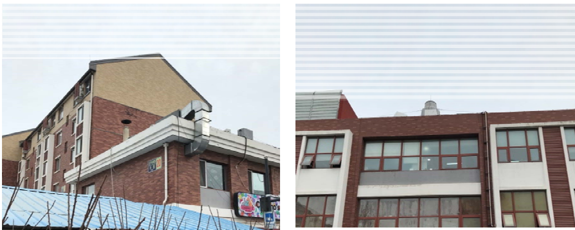
图 4.1-3 本项目锅炉废气排气筒情况
